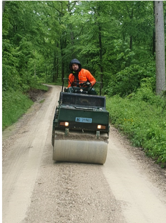
2021 wurden überdurchschnittlich viele Kilometer Waldstrassen neu überkiest.
