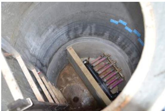
Von diesem Verteilschacht aus führen die Leitungen zu den acht unteren Brunnen.
