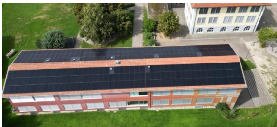
PV- Anlage Schulhaus Brühl Jahresproduktion 2023: 103,39 MWh
